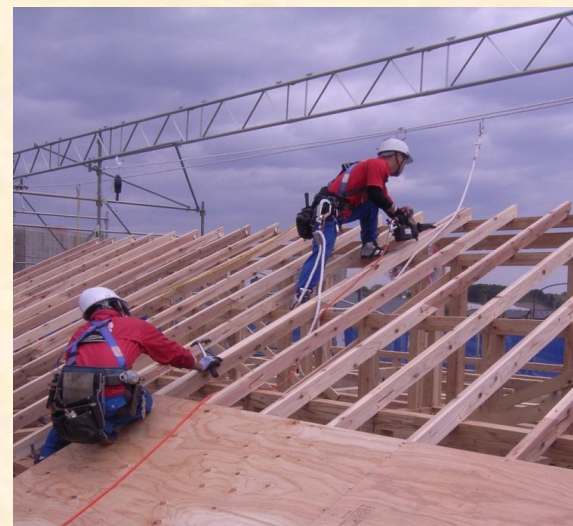
親綱・子綱による上棟作業
