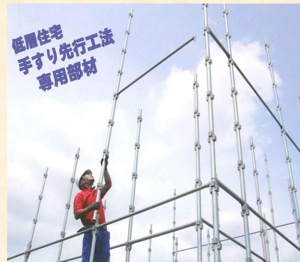
支柱にあらかじめ先行手すりを取付ける方式
