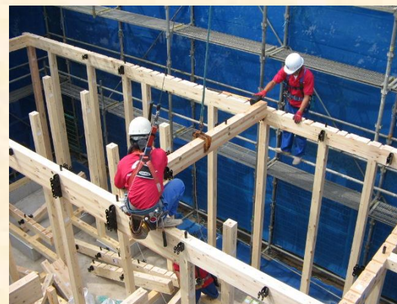
安全ブロックとフルハーネスによる上棟作業
