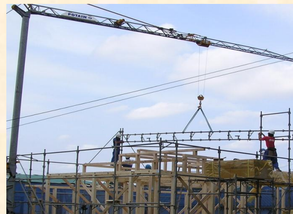
住宅用電動クレーンによる頭つなぎ施工
